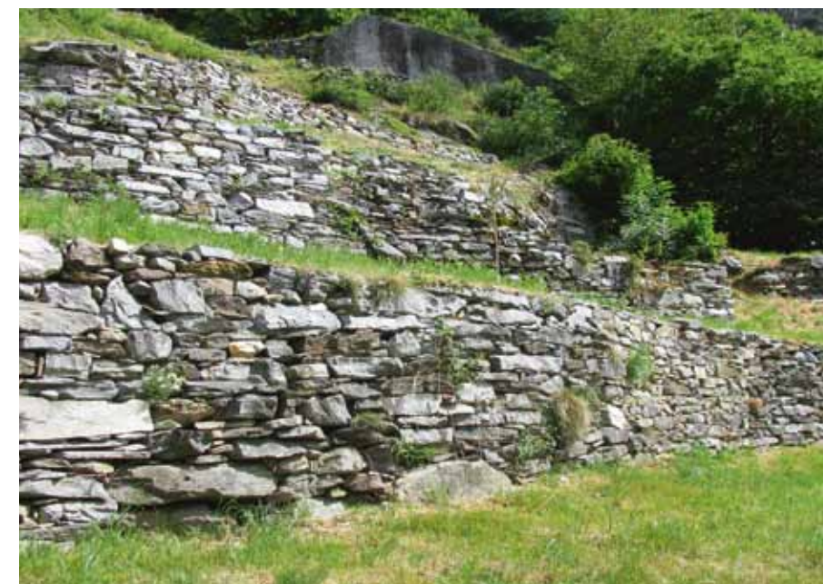
Murs de pierres sèches
